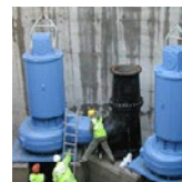
IRLAND Druckerhaltung bei Pumpenstationen
